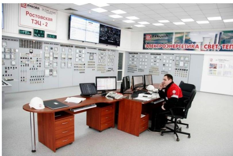
Система отображения включает видеостену, состоящую из двух блоков (2 x 4 модуля каждая, и мониторы операторов. В качестве модулей видеостены использованы ЖК панели NEC MultiSync X462UN. Эта модель отлично подходит для установки в условиях работы при высоком уровне яркости и при режиме работы «на износ» (возможность непрерывной работы 24 часа 7 дней в неделю), что типично для ТЭЦ.
