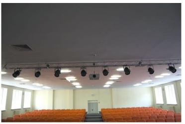
Концертный ОТ компаниисвет производителя световых приборов на Highendled основе светодиодов смонтирован на штанге перед сценой. Всего установлено 6 световых приборов, которые обеспечивает основные варианты подсветки сцены. Приборы являются универсальными источниками света и поддерживают множество режимов работы (затухание, постоянный свет, мерцание). Каждый может светить одним из семи хроматических цветов.
