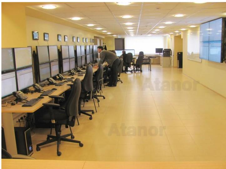
Атанор смонтировал в зале стенда видеостену из 4-х узкошовных ЖК панелей для моделирования процессов отображения информации на видеостенах в ЦОВ системы-112, а также взаимодействия с администрациями субъектов Российской Федерации и муниципальных образований.
