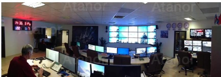
Вся система коммутации построена на цифровых технологиях, что позволяет осуществить все требуемые функции работы ситуационного центра без потери качества исходного сигнала. Вспомогательным устройством для удобства работы с сигналами различных форматов являются масштабаторы от компании TV-one, которые преобразуют как аналоговые так и цифровые сигналы в DVI-формат.
