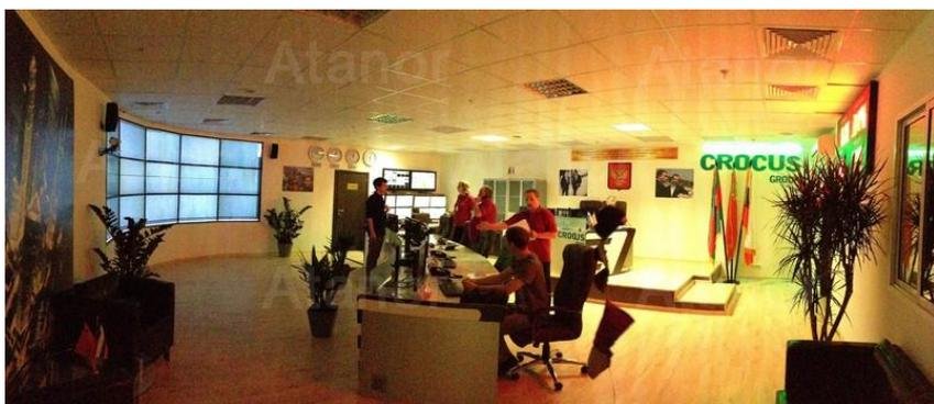
Система отображения включает видеостену 3×5 на жидкокристаллических панелях NEC. Видеостена работает как в режиме одного экрана, так и в многооконном, что позволяет оперативно комбинировать потоки информации.
