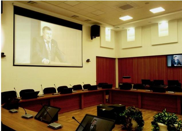
Система видеотрансляции зала включает мощный проектор Panasonic, который проецирует изображение на большой 4-метровый экран, 4 ЖК-панели NEC, расположенные на стенах, и мониторы на центральном столе совещаний. Место докладчика оборудовано сенсорным монитором, благодаря которому выступающий может легко управлять презентацией и выводить на экраны необходимую информацию. В зале также расположены 3 поворотные HD камеры с
